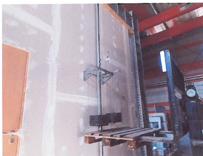
Figura 15: Ensaio de carga vertical excêntrica – dano estrutural.
